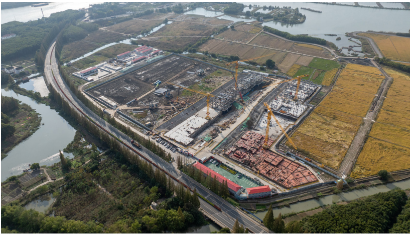
► 创智引擎施工现场
