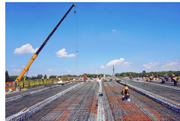
▶ “水乡客厅”重点建设项目——浦港路东延工程
