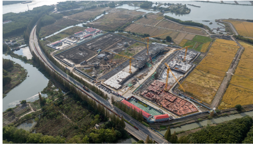
▶ 创智引擎施工现场
